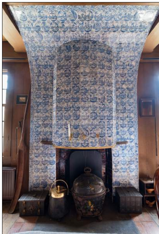
Afb. 4.47. Smuiger in de consistorie van de Zuidervermaning in Amsterdam, gebouwd in 1731. Rond de haardplaats zijn eveneens gehalveerde tegels met gemarmerde mangaan-beschildering aangebracht.
