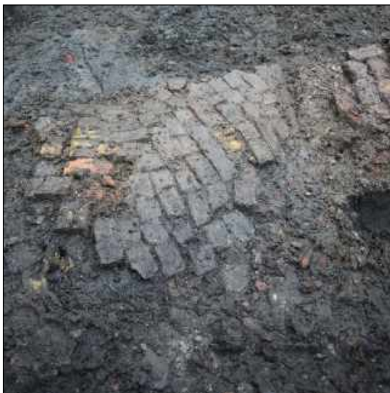
Afbeelding 59. Bakstenen straatwerk in kepermotief. Waarschijnlijk liep deze naar het entree van het koetshuis.
