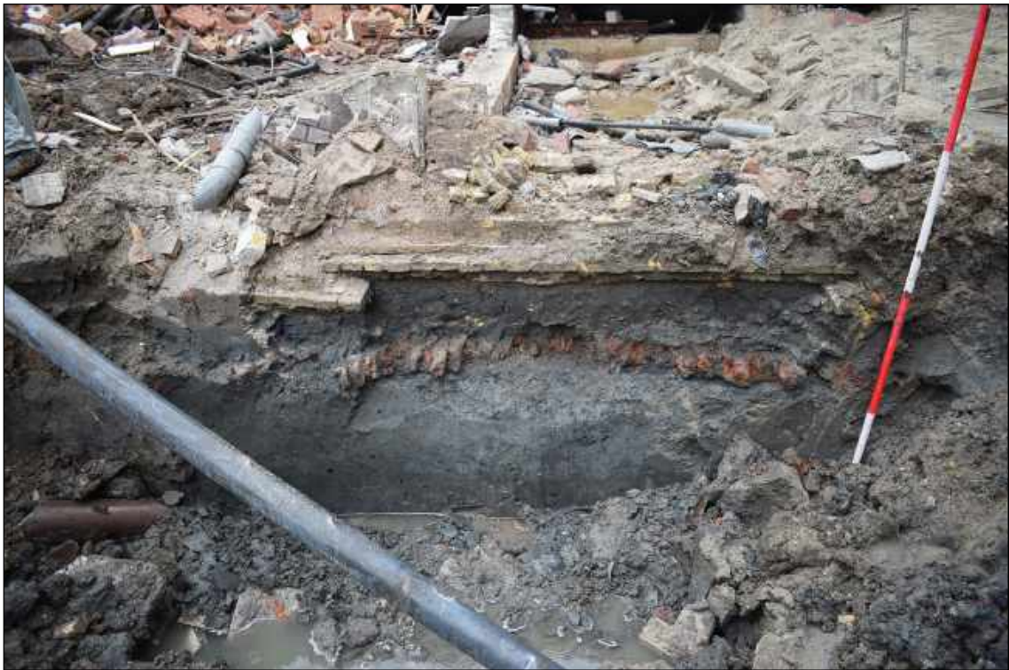
Afbeelding 20. De 17 de -eeuwse fundering op een egalisielaag van donkergrijze klei met baksteenpuin en mortel. Daaronder ligt de bakstenen vloer van de 16 de -eeuwse voorganger.
