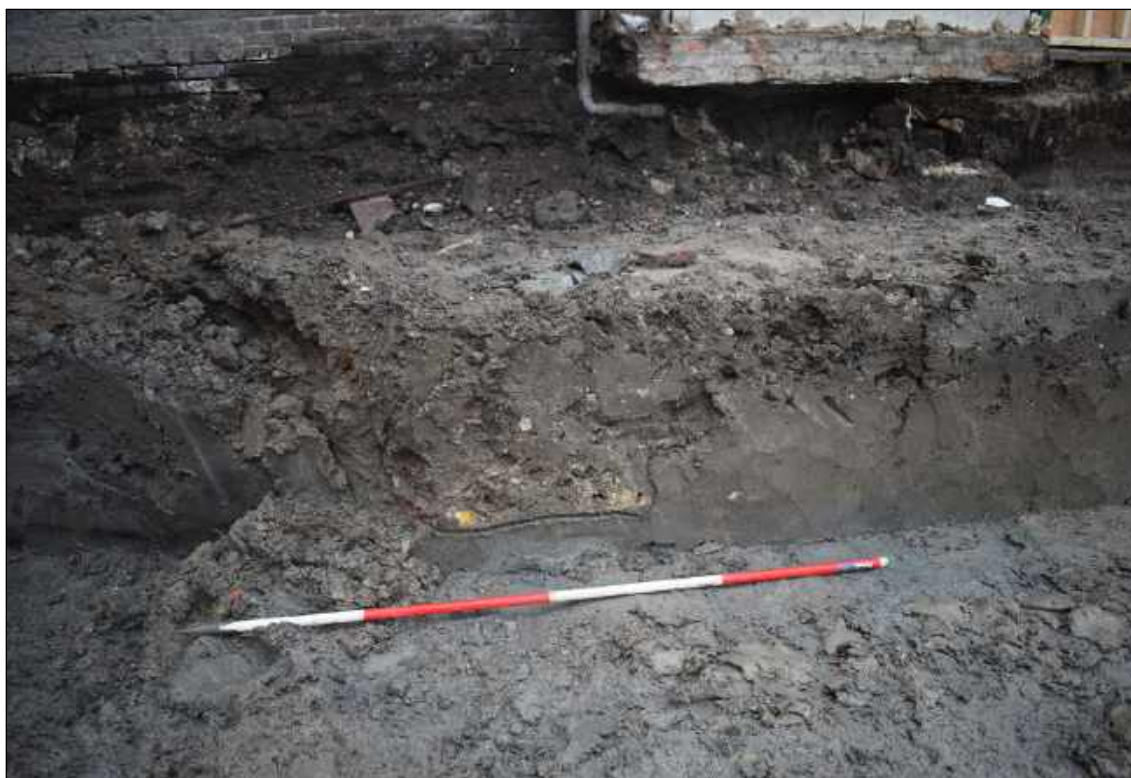
Afbeelding 28. In het oostprofiel van werkput 1 was een uitbraakspoor zichtbaar dat precies in het verlengde van de fundering S13 en uitbraakspoor S26 lag.
