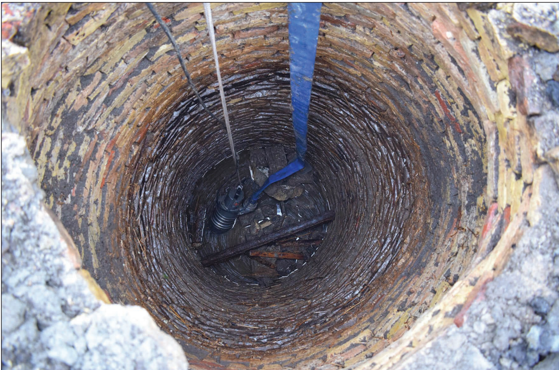
Afb. 99. Een blik in het ronde ondergrondse deel van de waterput. De pomp voor het wegpompen van het grondwater ligt er nog in.
