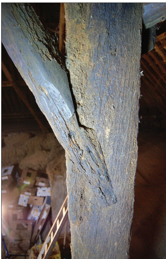
Afb. 52. Lipverbinding met hak op de noordoostelijke stijl.
