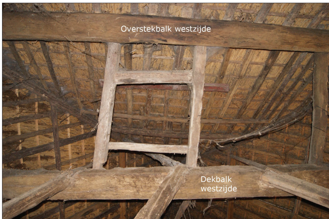
Afb. 38. Raamwerk van een verdwenen rookkanaal tussen de westelijke dekbalk en de overstekbalk, van onder gezien.
