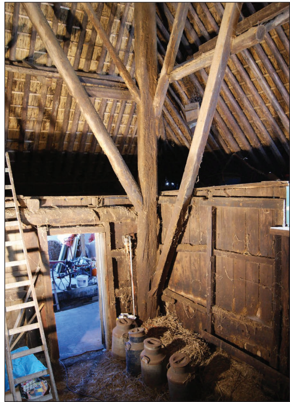
Afb. 25. Houten wanden rondom de hooiberg, gezien richting de noordwesthoek van de boerderij.
