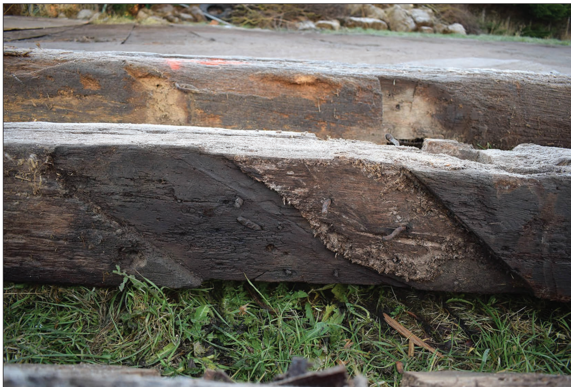
Afb. 54. Inkeping voor lipverbinding met hak op de zuidoostelijke stijl. Aan de rechterzijde van de inkeping is de afdruk van de zwing zichtbaar (lichter van kleur), deze is veel kleiner dan de inkeping.
