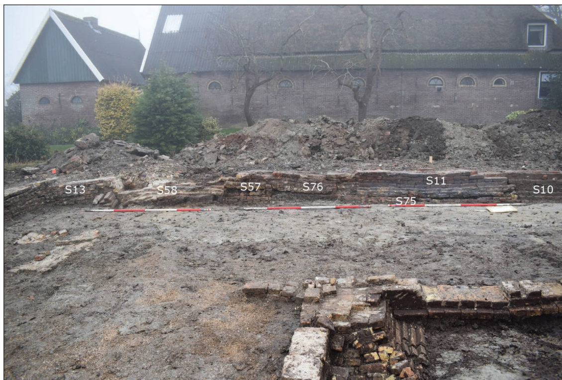
Afb. 83. Noordelijk deel van de fundering van de oostelijke zijgevel.
