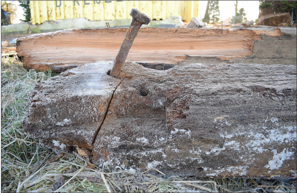
Afb. 45. Zaagsnede in de oostelijke dekbalk.
