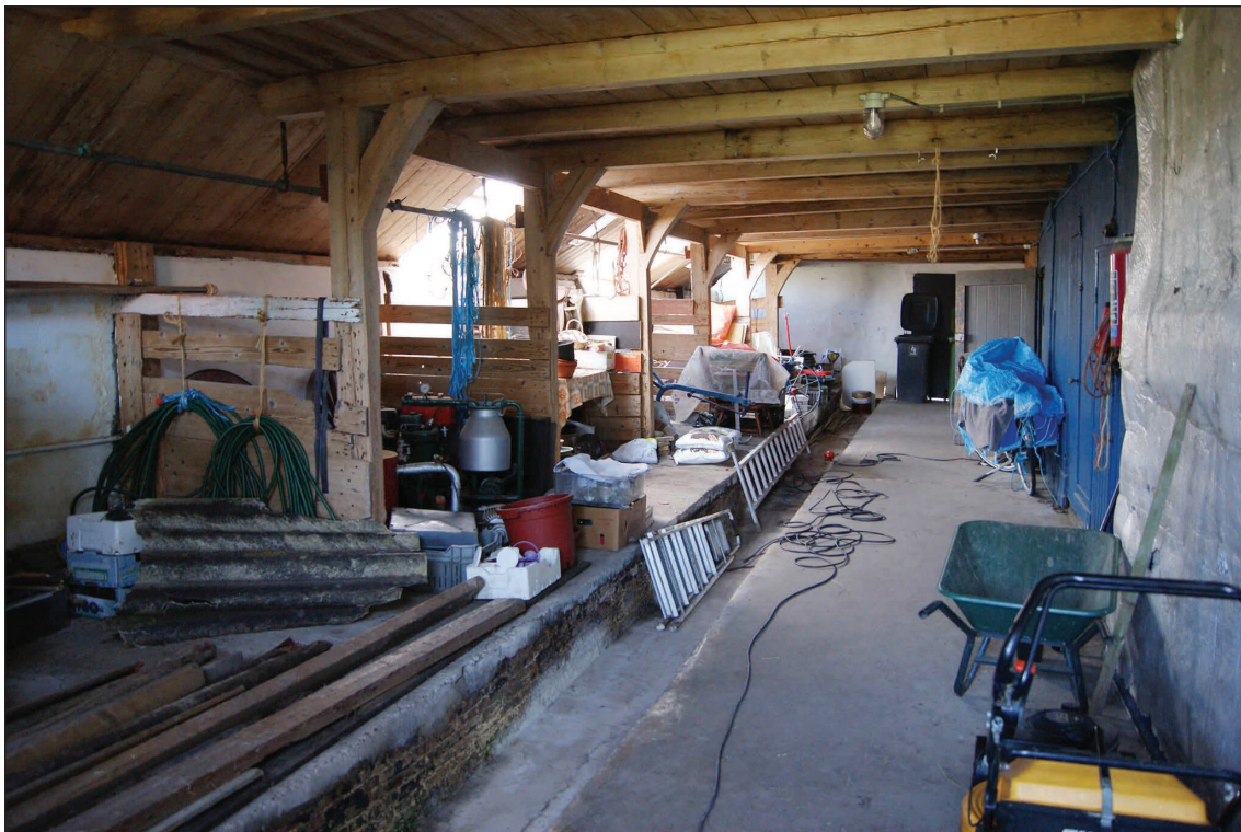
Afb. 28. De stal aan de achterkant van de boerderij, gezien richting het oosten.
