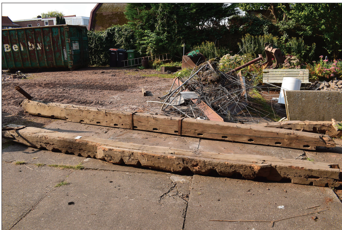
Afb. 52. De overstekbalk (achter) met gaten voor de heklatten.
