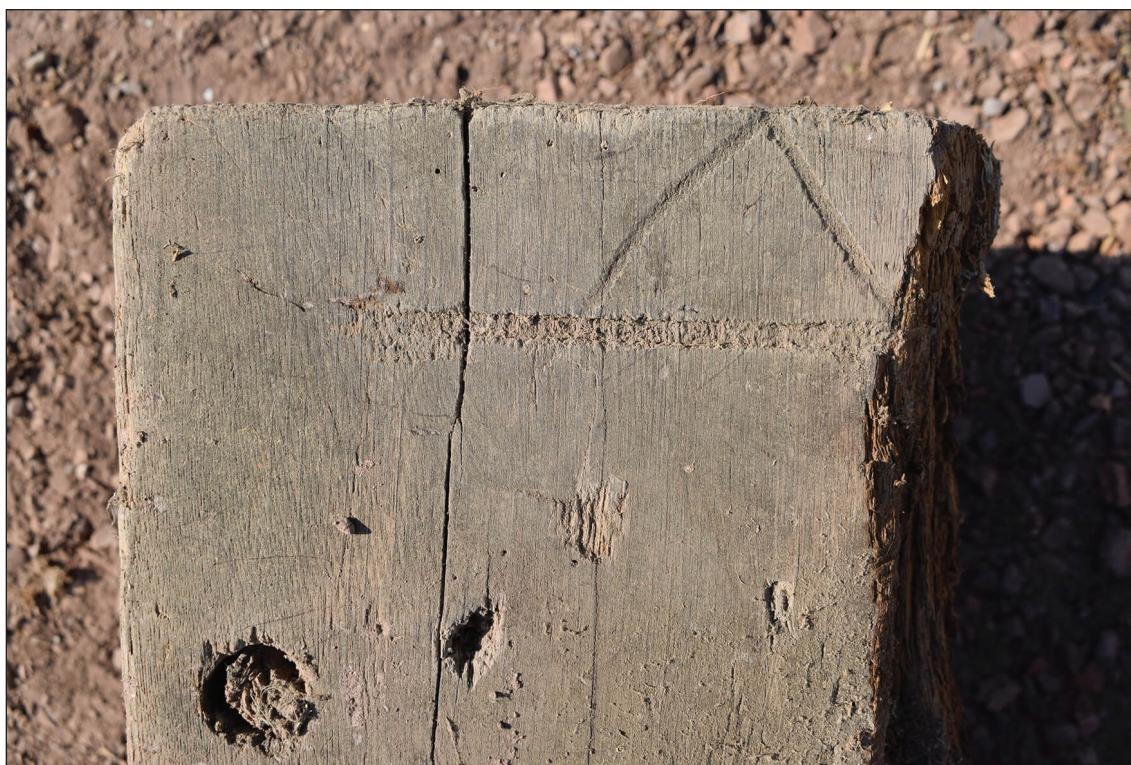
Afb. 61. Merk op de kop van de zuidelijke dekbalk.
