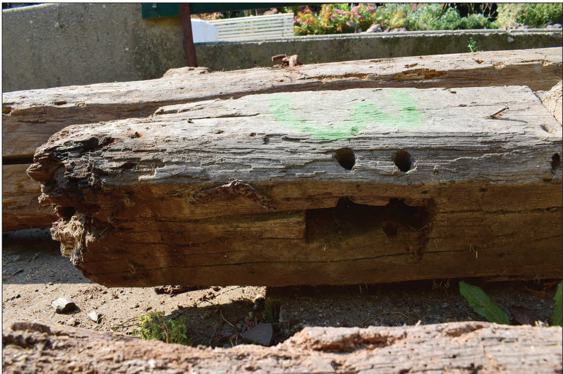
Afb. 45. Een pengat onderin de noordoostelijke stijl, horende bij de primaire functie van de balk.
