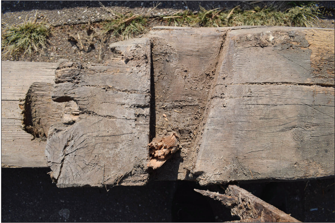
Afb. 40. Loef in de onderzijde van de zuidkop van de oostelijke bovenbalk. Hierin bevindt zich een verbindingspen van naaldhout.
