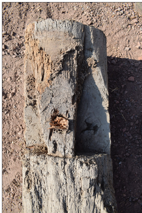
Afb. 37. Voorloef in de bovenzijde van de oostkop van de zuidelijke dekbalk. Hierin bevindt zich een verbindingspen van naaldhout.
