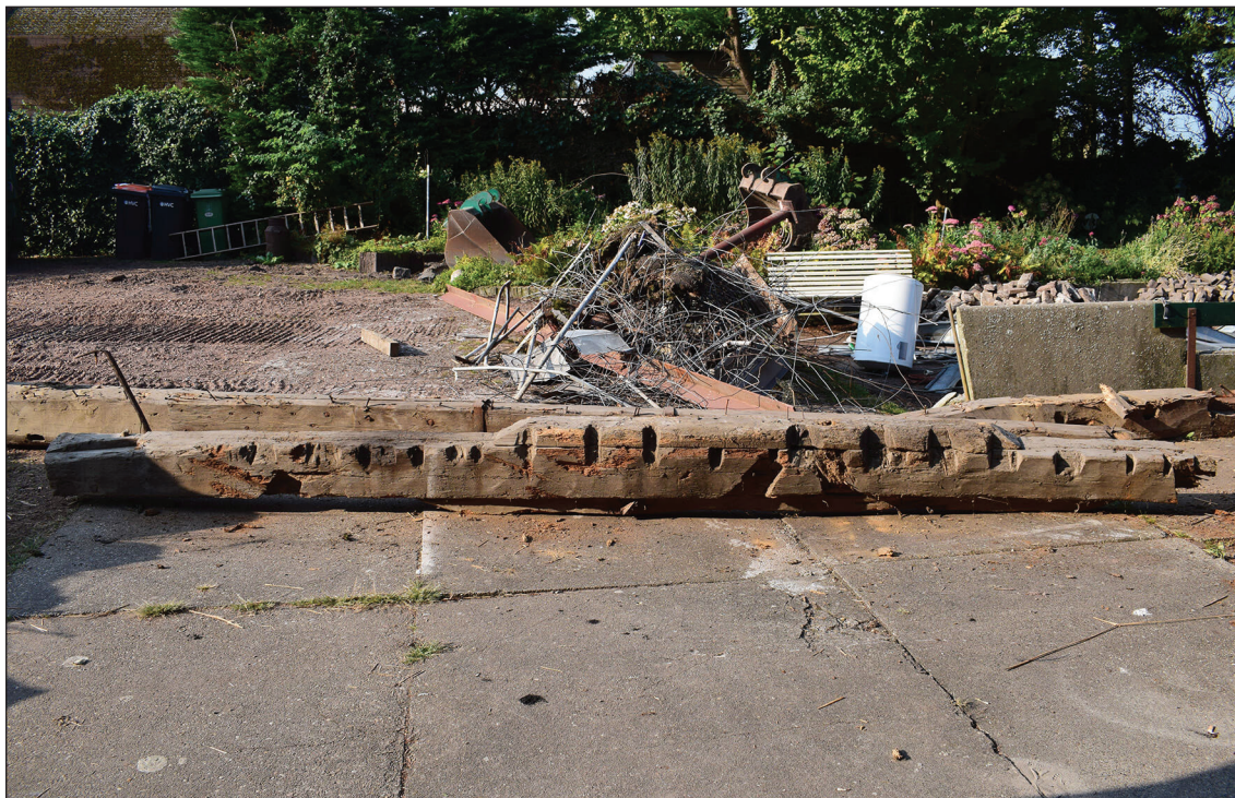
Afb. 49. Inkepingen voor sparren in de zuidelijke dekbalk, waarschijnlijk horende bij de primaire functie van de balk.
