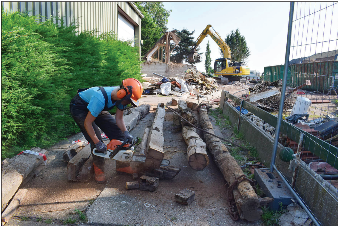
Afb. 131. Uit de balken van het vierkant worden houtmonsters gezaagd. Op de achtergrond worden de laatste delen van de boerderij gesloopt.
