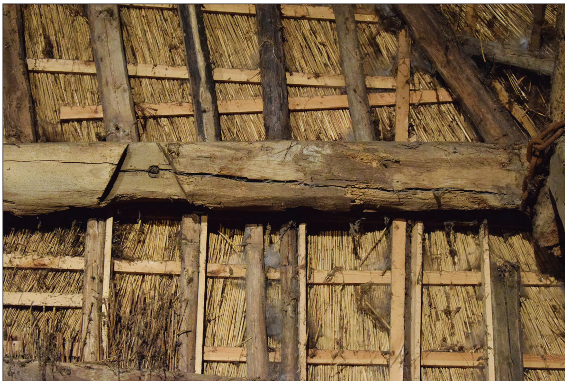
Afb. 50. Loef in de onderzijde van de westelijke bovenbalk, horende bij de primaire functie van de balk.
