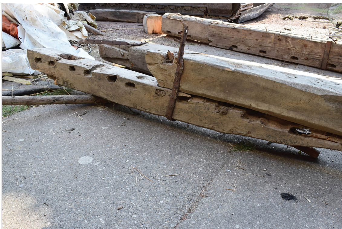
Afb. 51. Verlengstuk aan de westelijke bovenbalk, de onderkant ligt boven.
