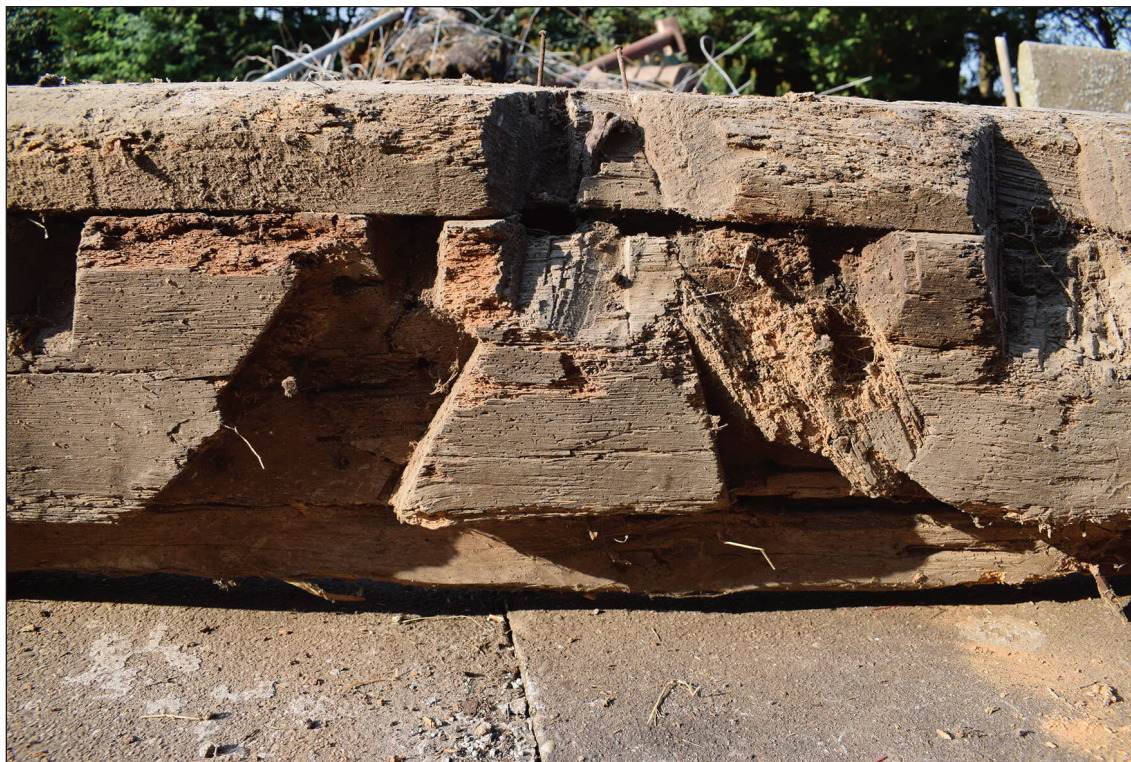
Afb. 48. Twee inkepingen voor zwingen in de zuidelijke dekbalk, horende bij de primaire functie van de balk.
