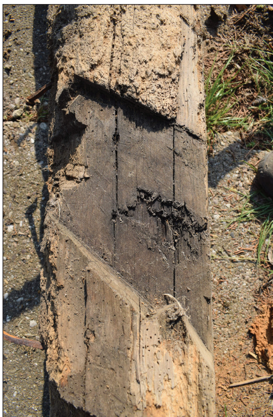
Afb. 47. Inkeping voor een zwing in de noordelijke dekbalk, horende bij de primaire functie van de balk.
