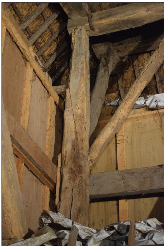
Afb. 46. De zuidoostelijke stijl, bestaande uit twee delen die door middel van een schuine liplas aan elkaar zijn verbonden.
