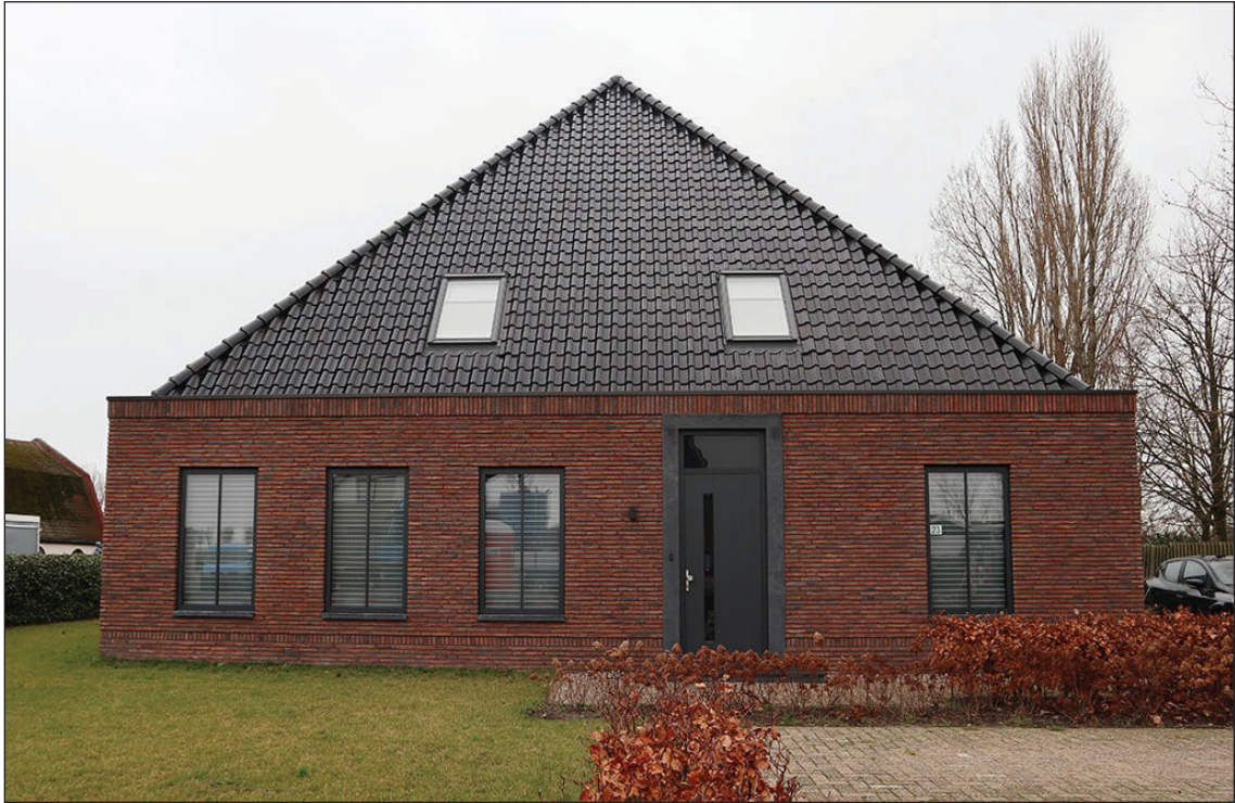
Afb. 132. De nieuw gebouwde stolpboerderij op het perceel.
