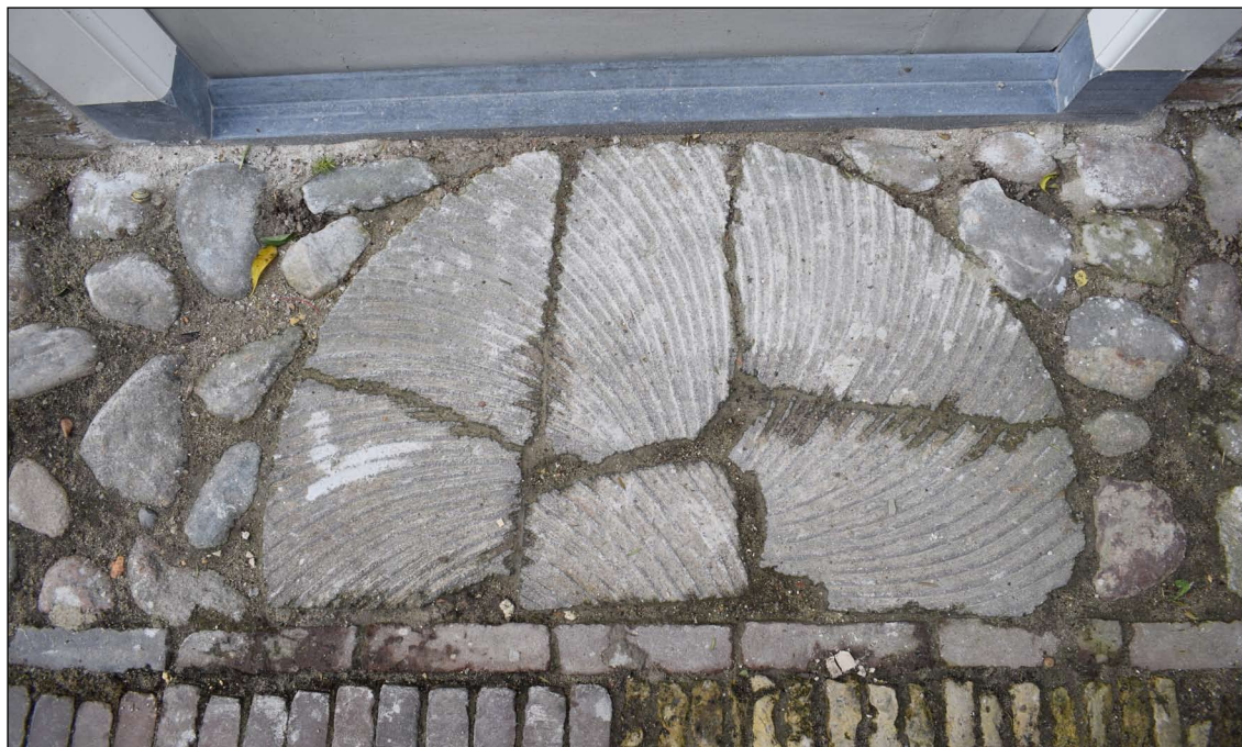
Afb. 47 Halve breeksteen voor de voordeur van het pand.
