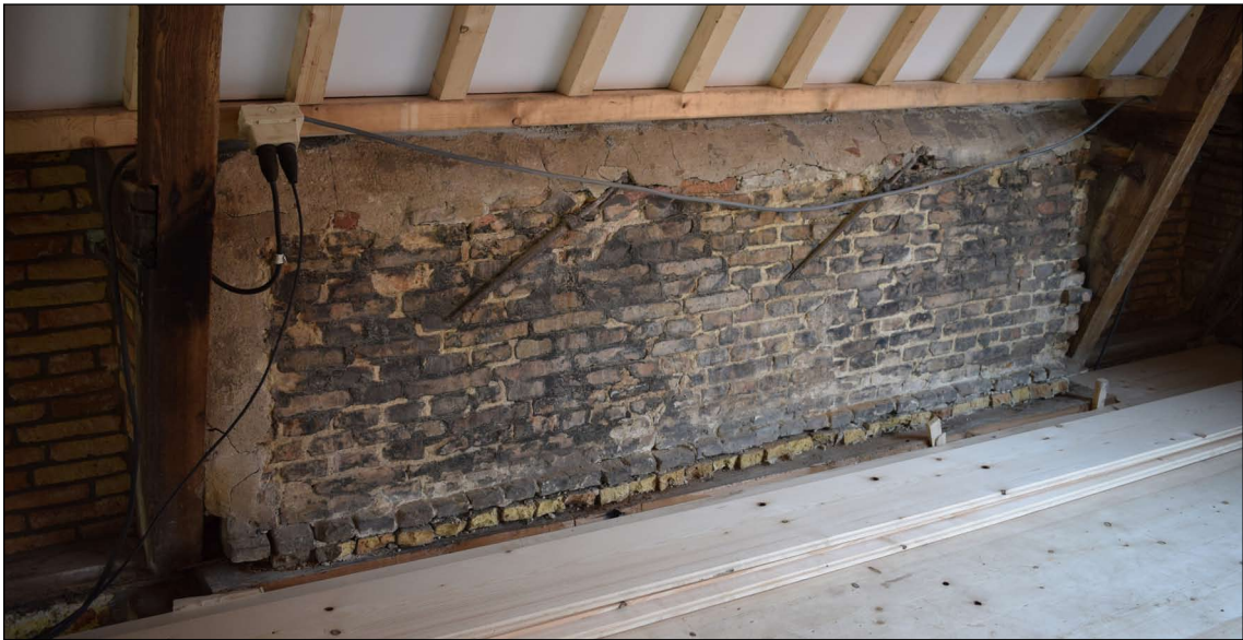
Afb. 52 De muur van de eest op de zolder.
