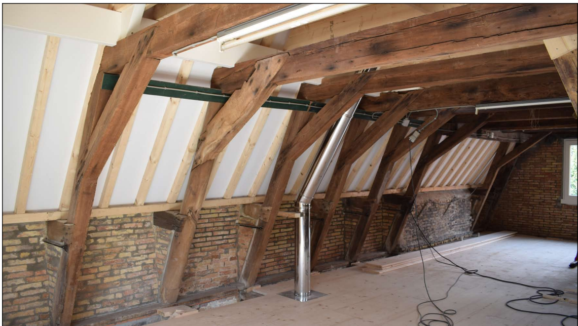
Afb. 40 Houtskelet van de zolder.
