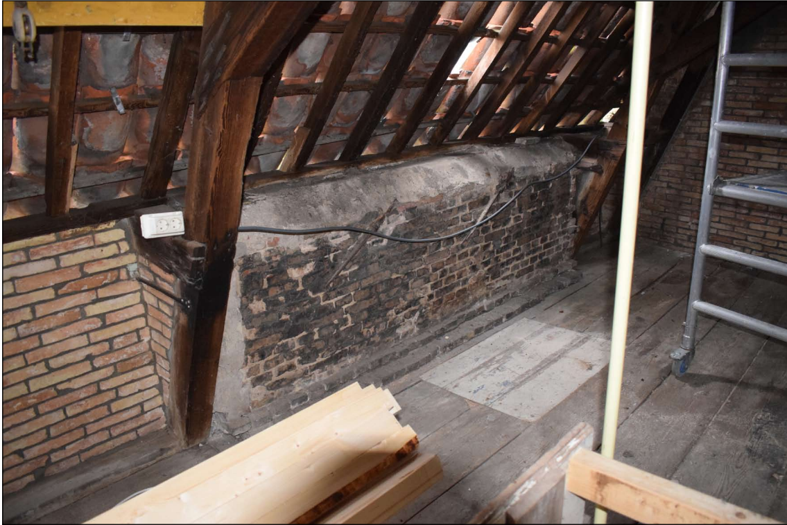
Afb. 54 De muur van de eest, foto genomen in december 2017. In de oude plankenvloer is een rechthoekig luik zichtbaar. Hier kwam het schoorsteenkanaal van de stookoven beneden in de eest uit.
