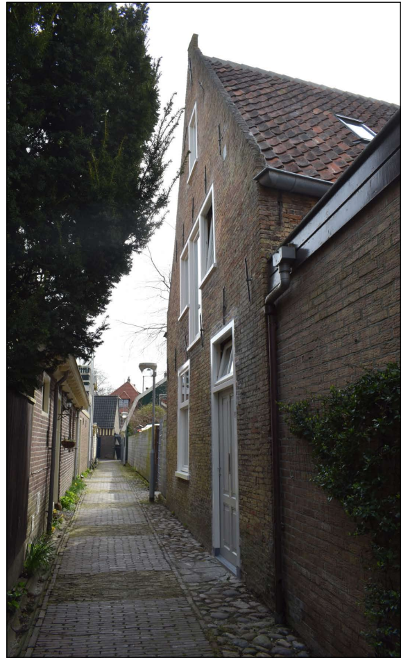
Afb. 39 De voorgevel van het pand aan de Vierbeentjes.
