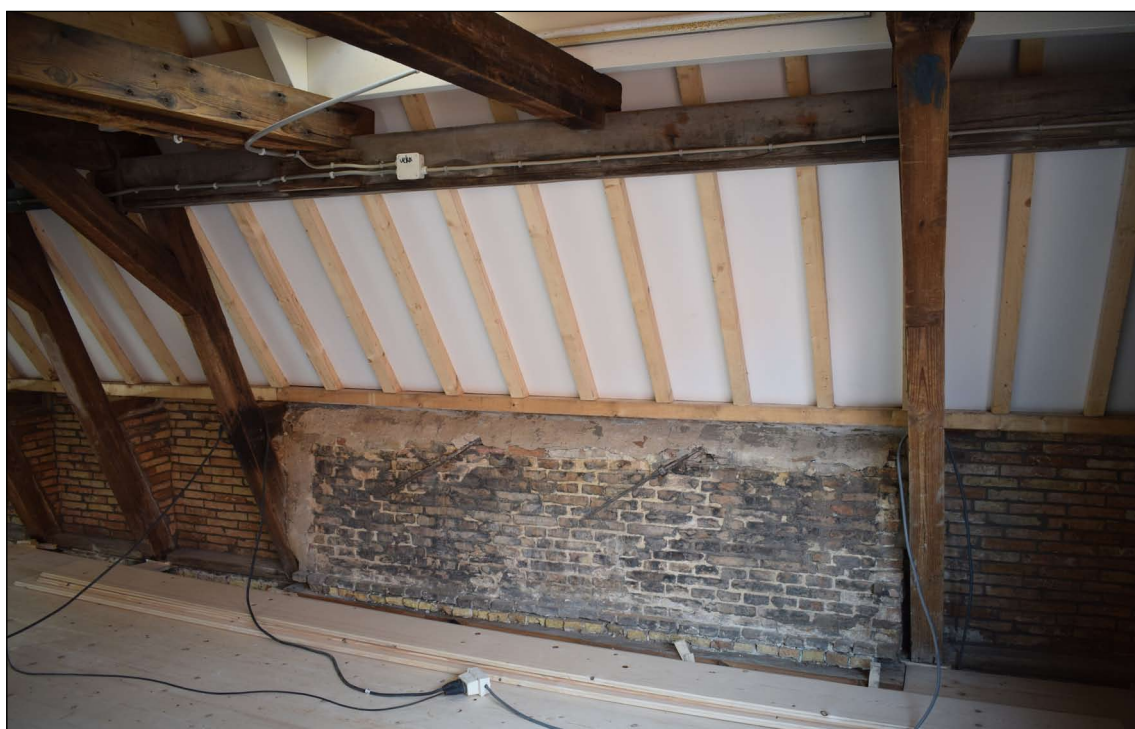
Afb. 51 De muur van de eest op de zolder. Twee schuine stijlen zijn bij de bouw van de eest verwijderd.
