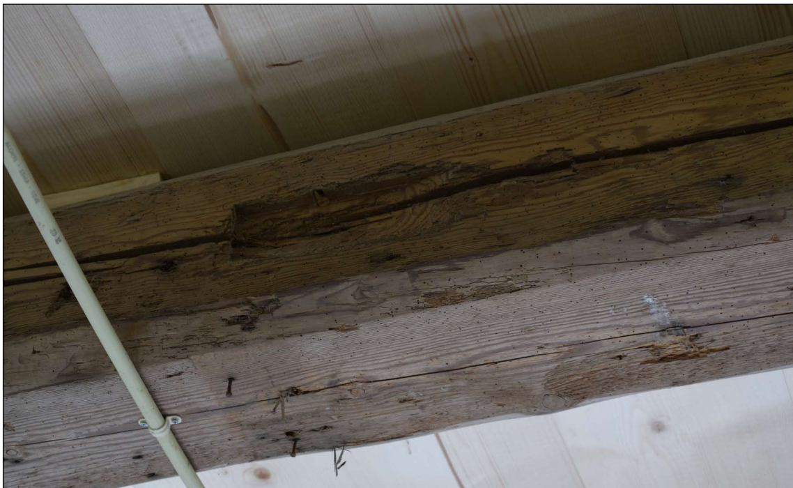
Afb. 49 Inkeping in de tiende balk vanaf de voorgevel, horende bij de bevestiging van de spil van de rosmolen.
