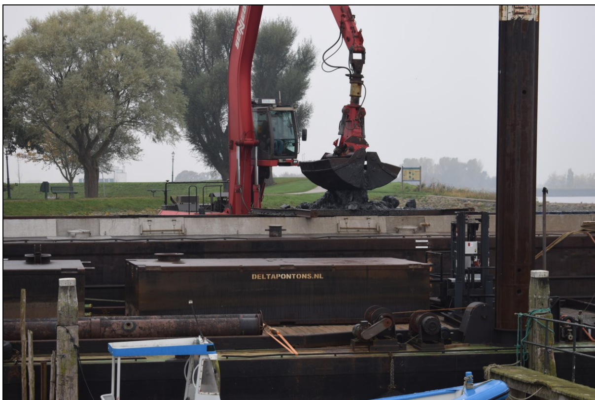
Afbeelding 11. De baggerspecie wordt van het kleine beunschip over het rooster in het grote beunschip gestort.
