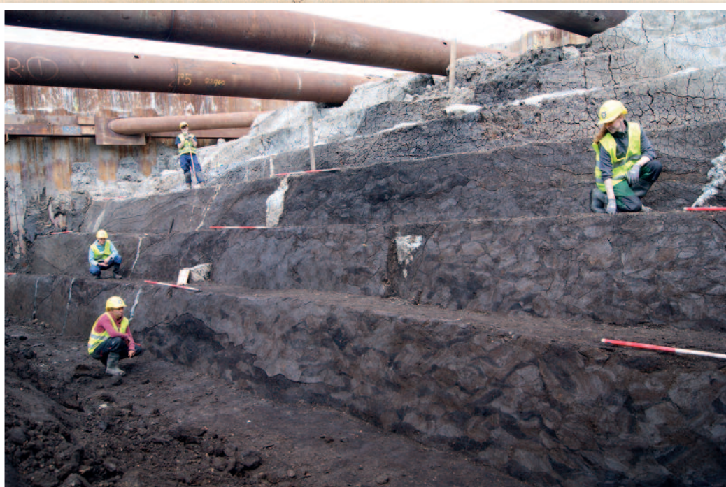
In de bouwkuip is trapsgewijs het profiel door de dijk aangelegd. Het bestaat uit massieve lagen van donkere humeuze zoden, waarmee het kolkgat uit de 15 de eeuw is gedicht.
