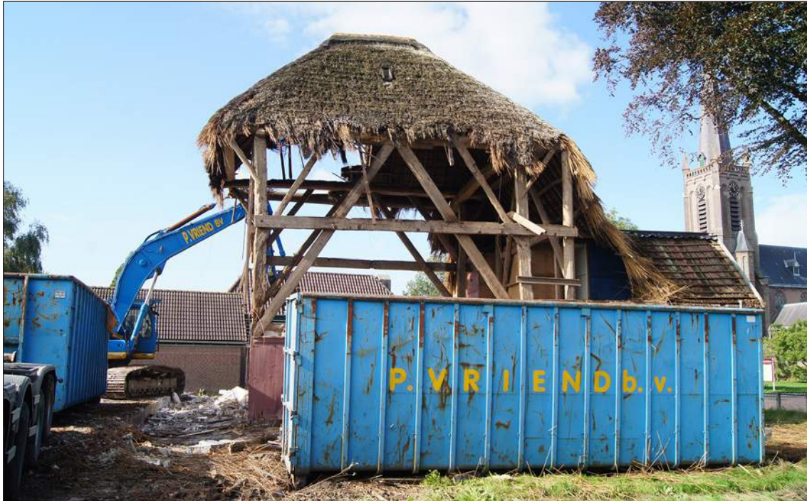
Afb. 57. Sloop van de boerderij.
