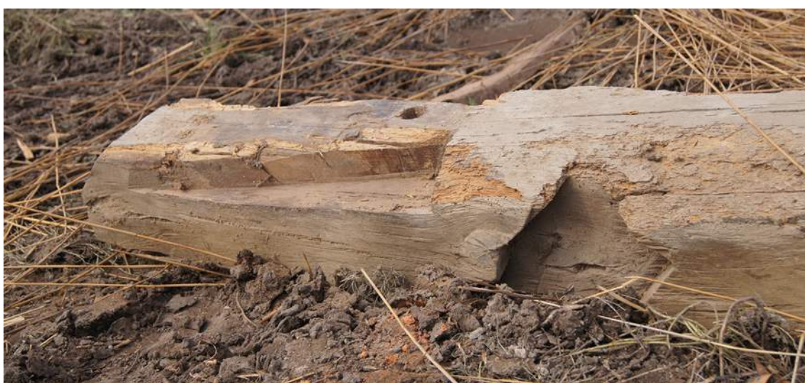
Afb. 91. Schuine inkeping voor een zwing in de noordkant van de noordelijke dekbalk. De inkeping hoort bij de primaire functie van de balk.
