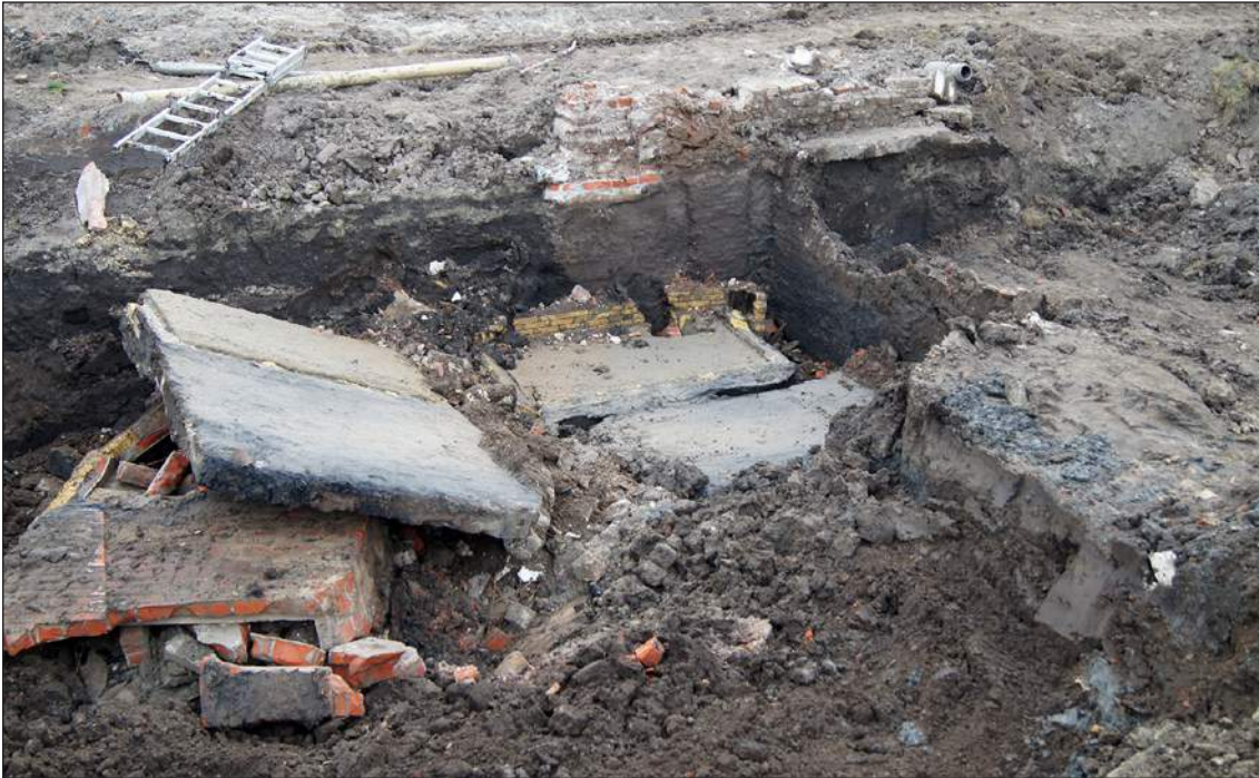
Afb. 118. Tijdens de sloop van een recente kelder aan het einde van het onderzoek kwam de bodem van een waterkelder tevoorschijn. Vermoedelijk zijn delen van deze waterkelder hergebruikt in de westelijke vierkantspoeren.
