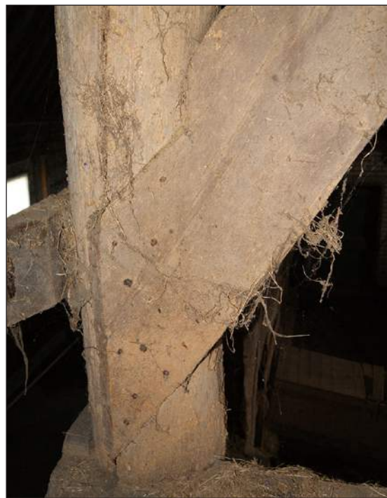
Afb. 103. Lipverbinding met zwaluwstaart van een zwing op van de extra stijlen.
