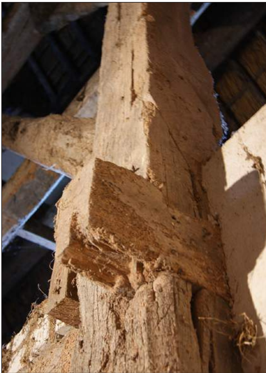
Afb. 105. Afgezaagde draagbalk op de noordwestelijke stijl.
