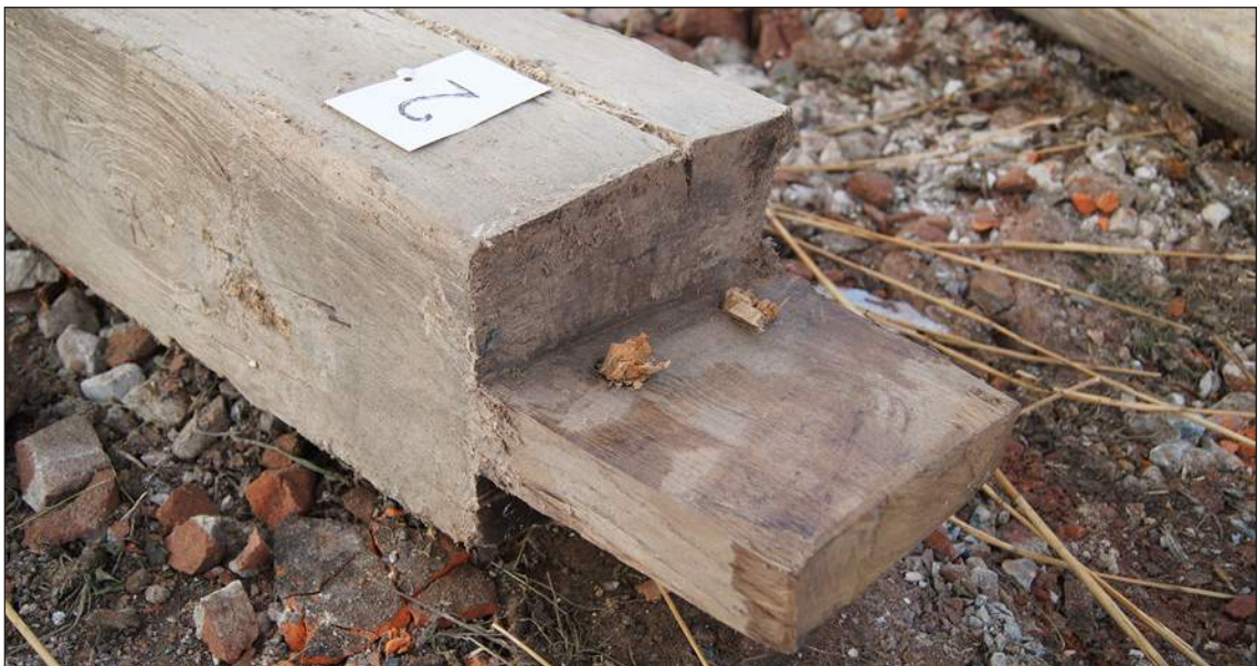
Afb. 95. Bovenkant van een stijl met een rechthoekige pen. In de pen zitten twee toognagels van naaldhout.
