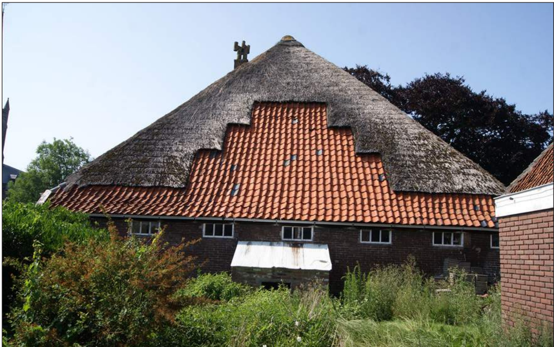
Afb. 70. De achtergevel van de boerderij.
