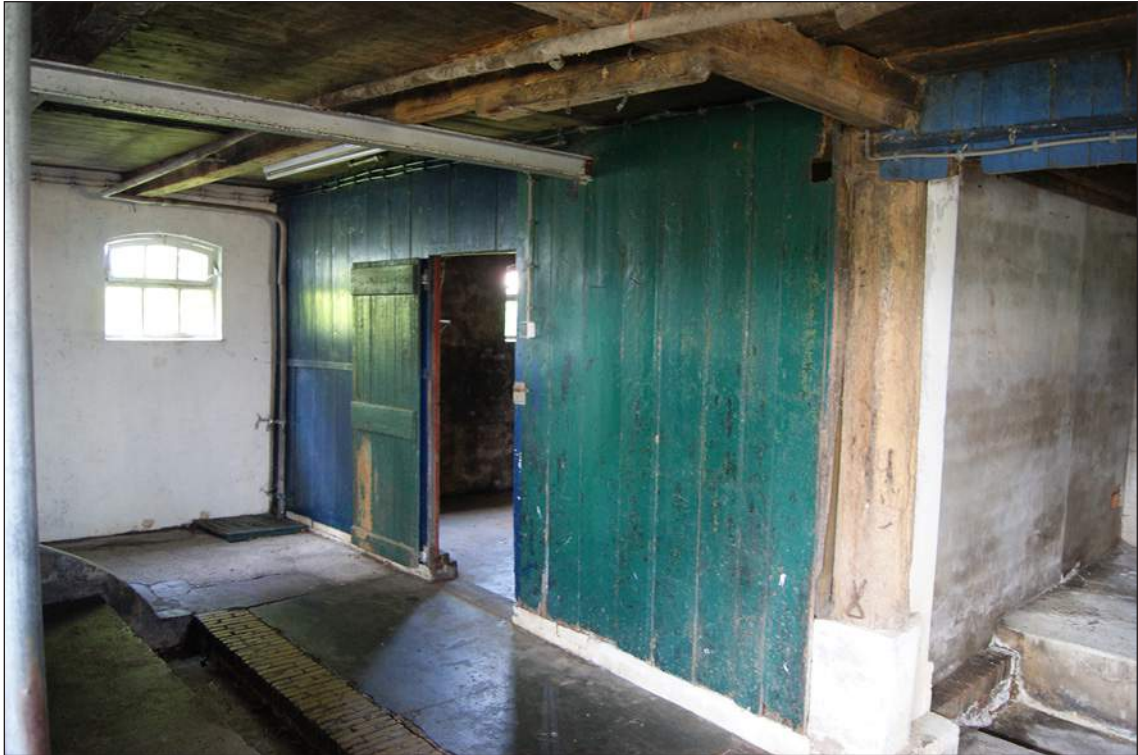
Afb. 114. Houten wand in de stolpschuur.
