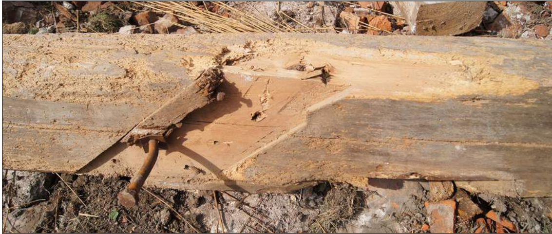
Afb. 101. Schuine inkeping met hak van een zwing.
