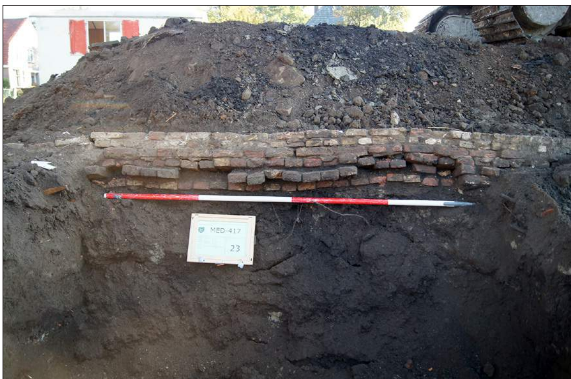
Afb. 124. Aan de oostzijde van de stolpboerdij kwam onder een betonnen plaat een oude fundering tevoorschijn. Het is niet duidelijk of dit om de oorspronkelijk fundering gaat die dateert uit de periode van de bouw, of dat het een latere verbouwing betreft.
