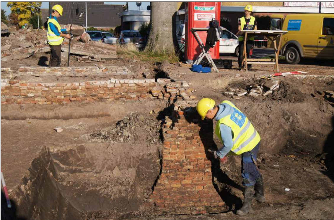
Afb. 119. De oostelijke vierkantspoeren bezaten aan de bovenzijde een min of meer rechte pilaar. Meer naar onder toe vertrapte de poer naar buiten. Dit is de noordoostelijke poer, S16.
