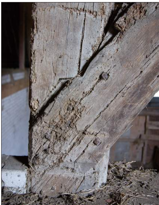
Afb. 102. Lipverbinding met hak van een zwing op een stijl.
