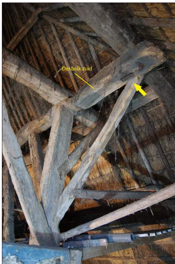
Afb. 92. Onderkant van de westkop van de zuidelijke dekbalk. Het pengat (bij de pijl) hoort bij de primaire functie van de balk.
