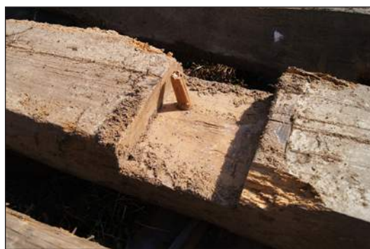
Afb. 98. Loef in de westelijke bovenbalk met houten pen.
