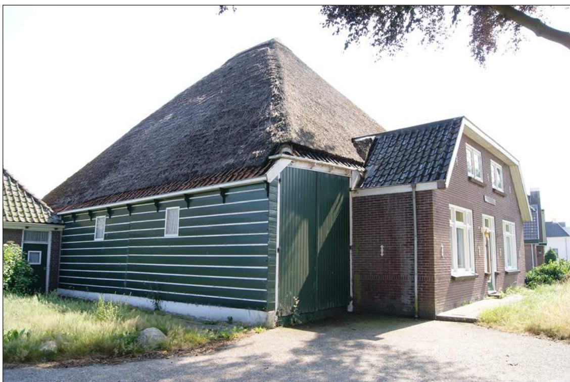
Afb. 68. De houten oostgevel van de boerderij met de darsdeuren in de voorgevel. Rechts het voorhuis.
