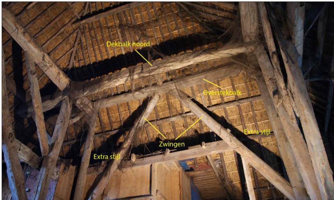
Afb. 86. Eikenhouten dekbalk aan de noordkant.
