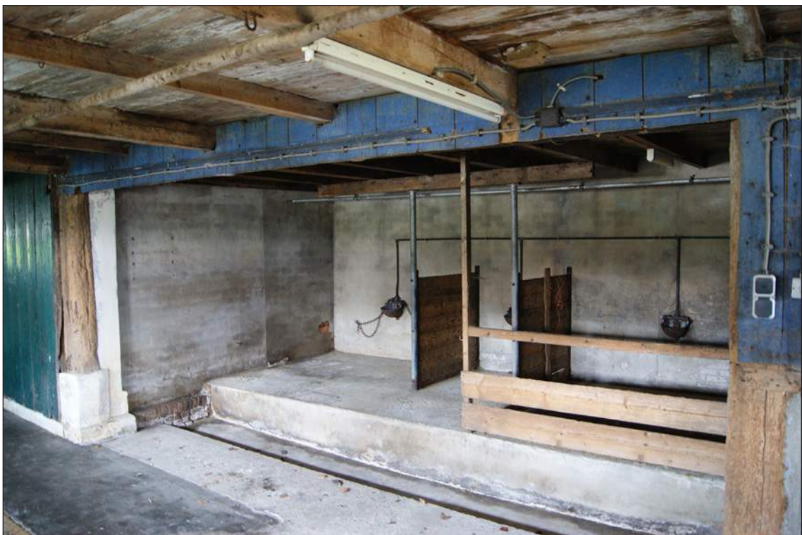
Afb. 115. De koeienstal op de plek van de oorspronkelijke hooiberg.
