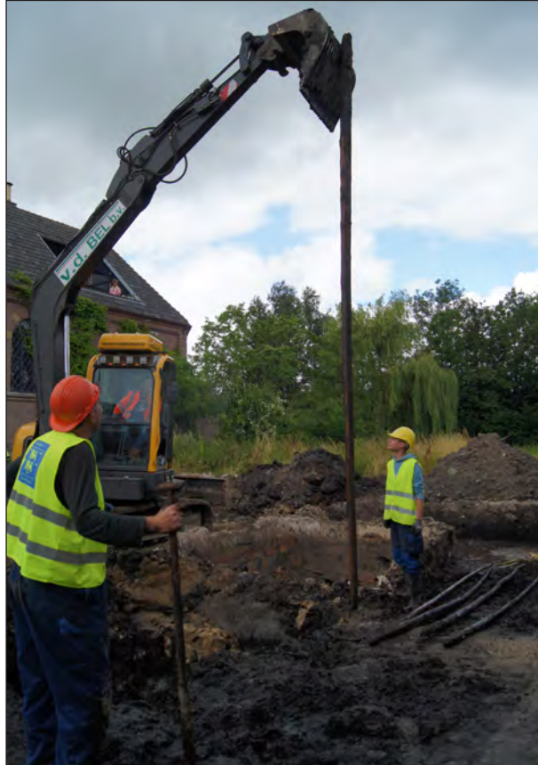
Afbeelding 21. Het trekken van de slieten uit de haardfundering van het langhuis.
