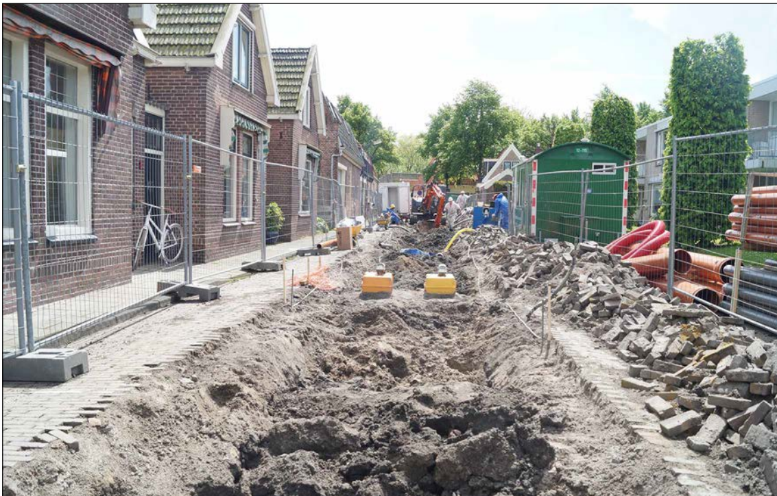
Afb. 14 Graafwerkzaamheden in de Romeinstraat.
