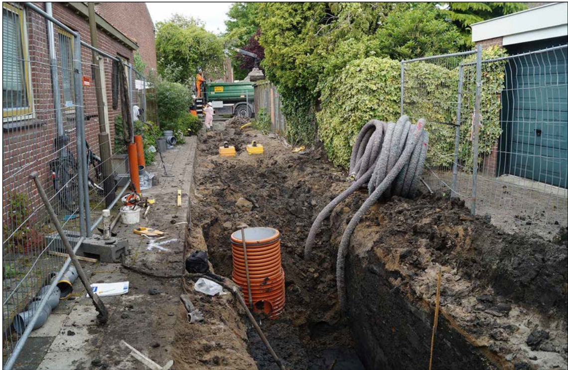
Afb. 15 Graafwerkzaamheden in de Korte Davidstraat.
