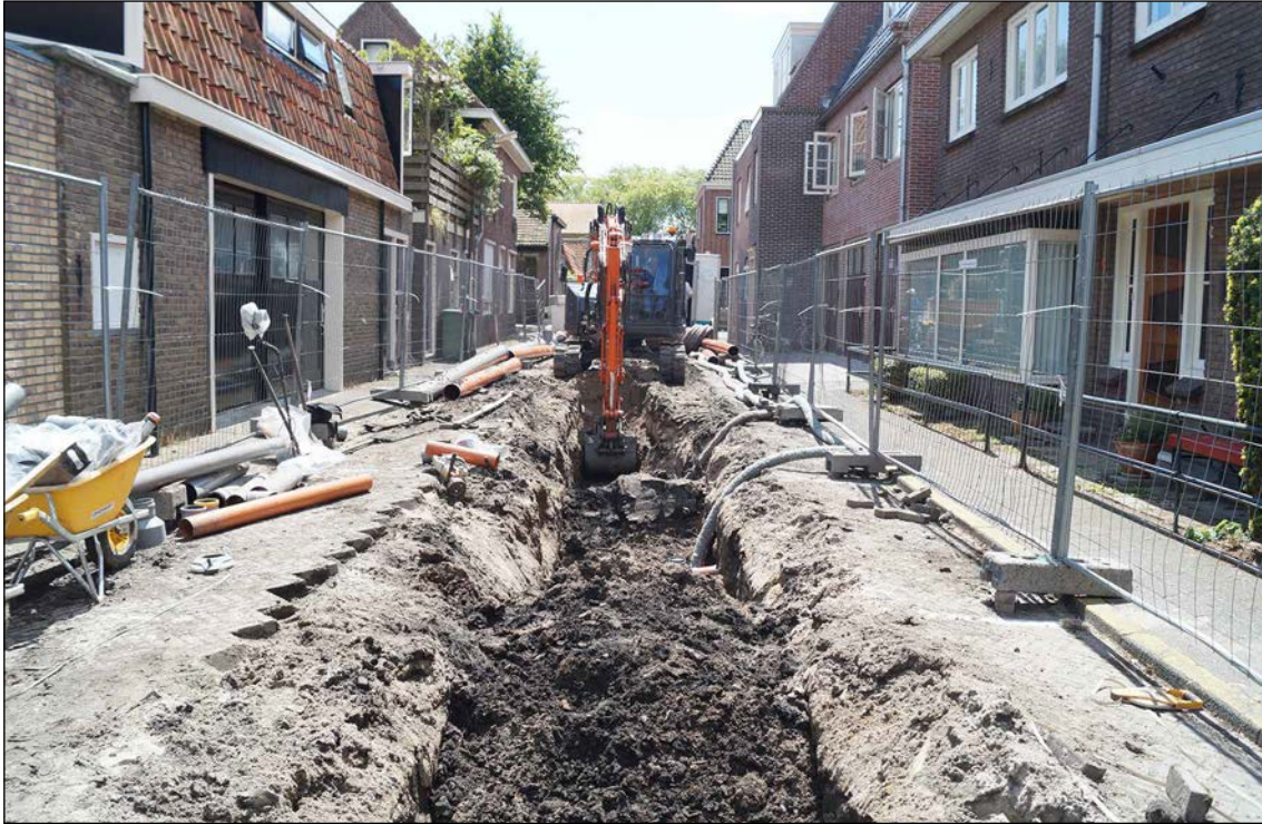
Afb. 13 Graafwerkzaamheden in de Davidstraat.
