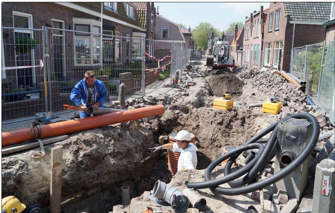
Afb. 16 Graafwerkzaamheden in de Kruislaan.
