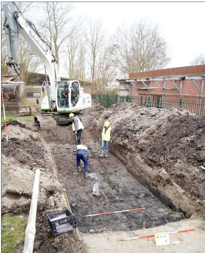
Afb. 86 Stratigrafisch vondsten verzamelen tijdens het machinaal couperen van een sloot. (S16, werkput 2). Foto is richting het westen genomen.
