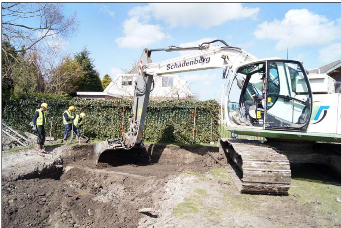
Afb. 18 Werk in uitvoering. Met behulp van een dieplepelkraan wordt een archeologisch vlak aangelegd. Hier wordt ten noorden van werkput 1 gegraven. Foto is richting het noordwesten genomen.
