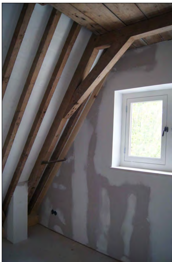
Afb. 35 De onderzijde van een van de A-spanten van de kap.
