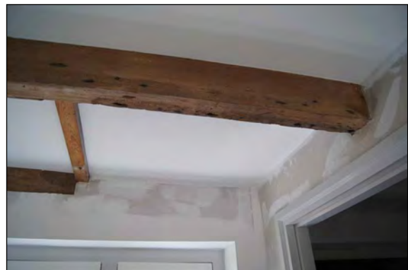
Afb. 32 Trapgat of hijsluik in de tweede balklaag.
