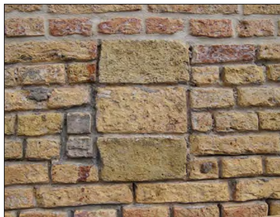
Afb. 20 De oostelijke zijgevel. Naast de muurankers zijn onregelmatigheden in het metselwerk aanwezig. Foto genomen tijdens de restauratie.
