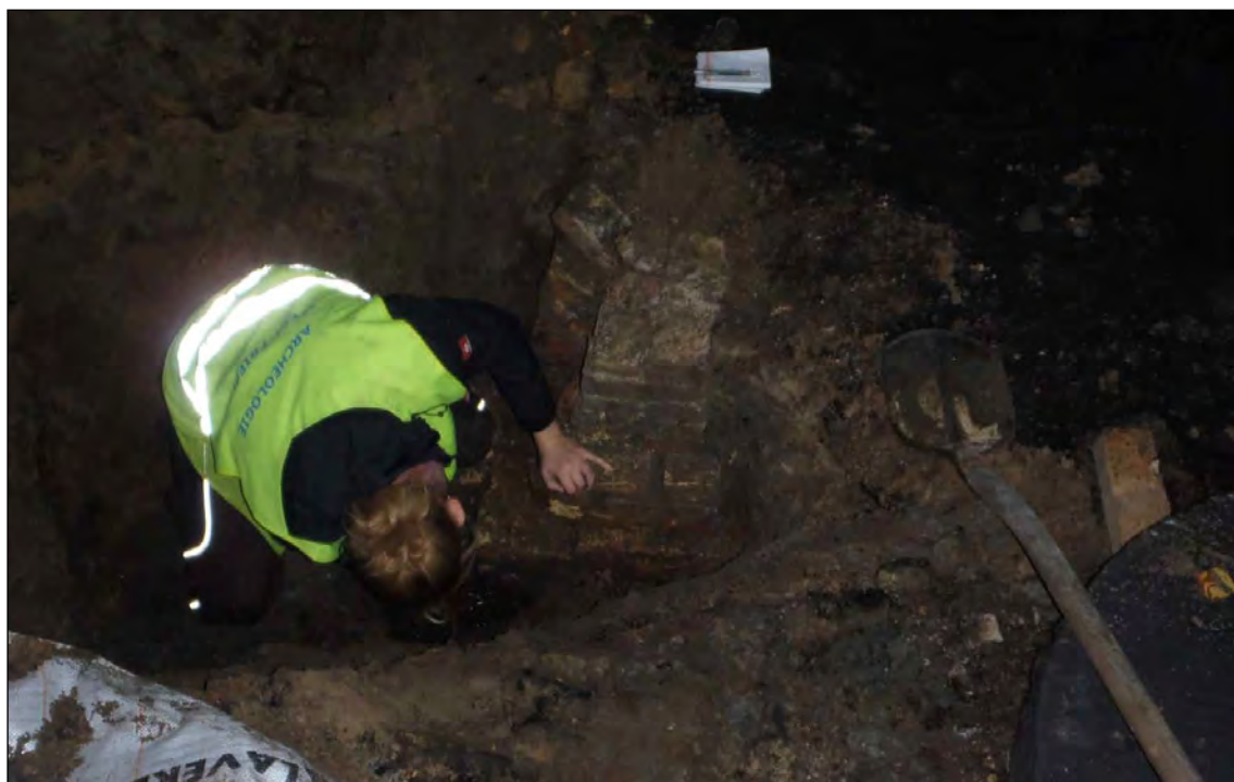
Afb. 45 Een van de poeren is uitgegraven om de diepte te kunnen bepalen.
