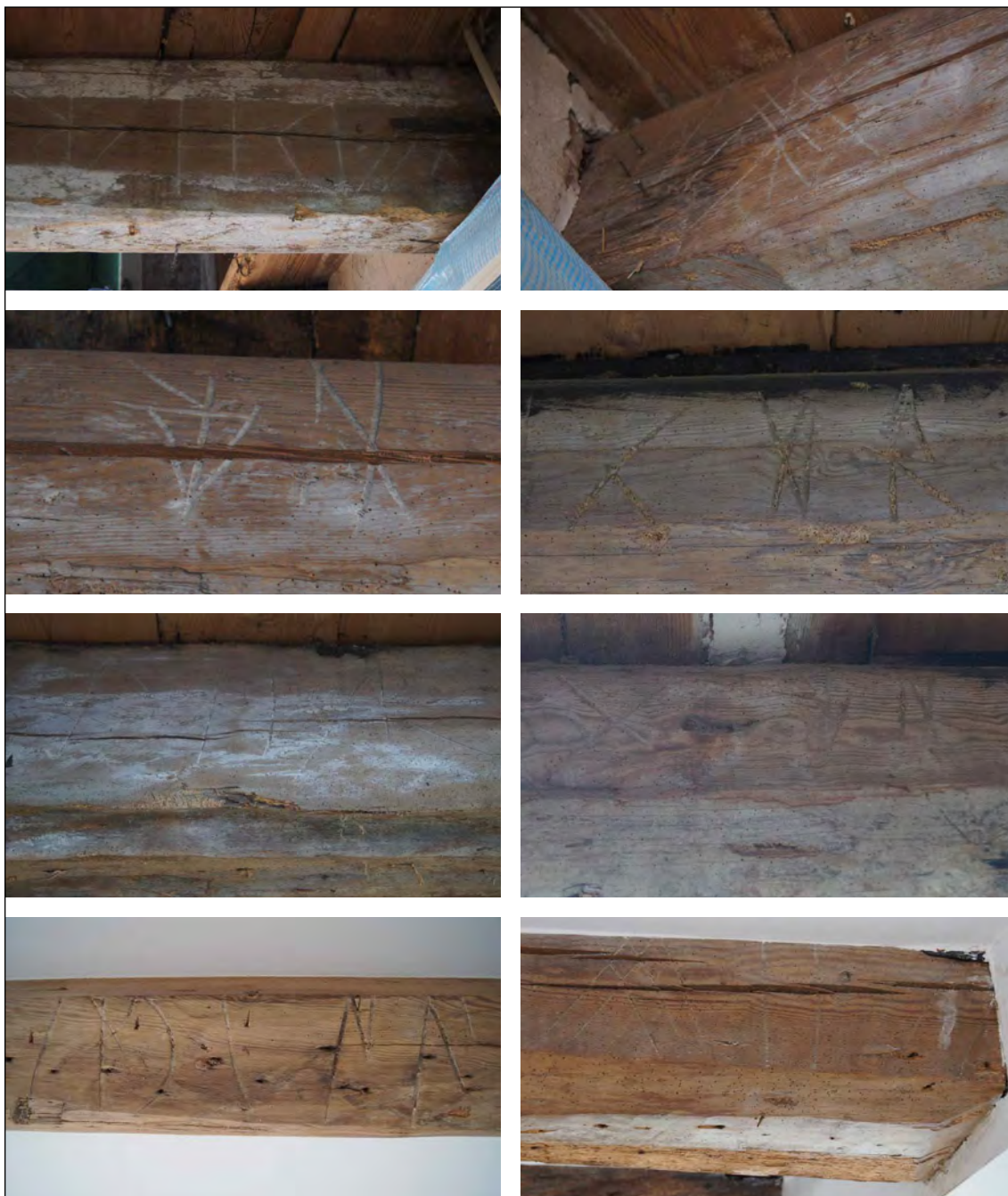
Afb. 27 Acht merken op balken van de tweede balklaag.
