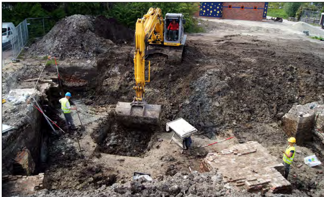
Afb. 51 Vanwege het extreme formaat werd de poeren van de stolpboerderij in de eerste instantie geïnterpreteerd als teerlingen van een standermolen.
