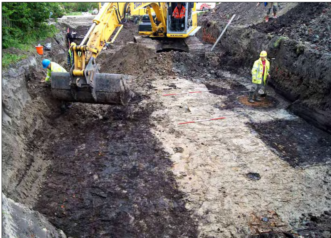
Afb. 8 Werk in uitvoering. Zuidzijde werkput 17. Foto is richting het noorden genomen.
