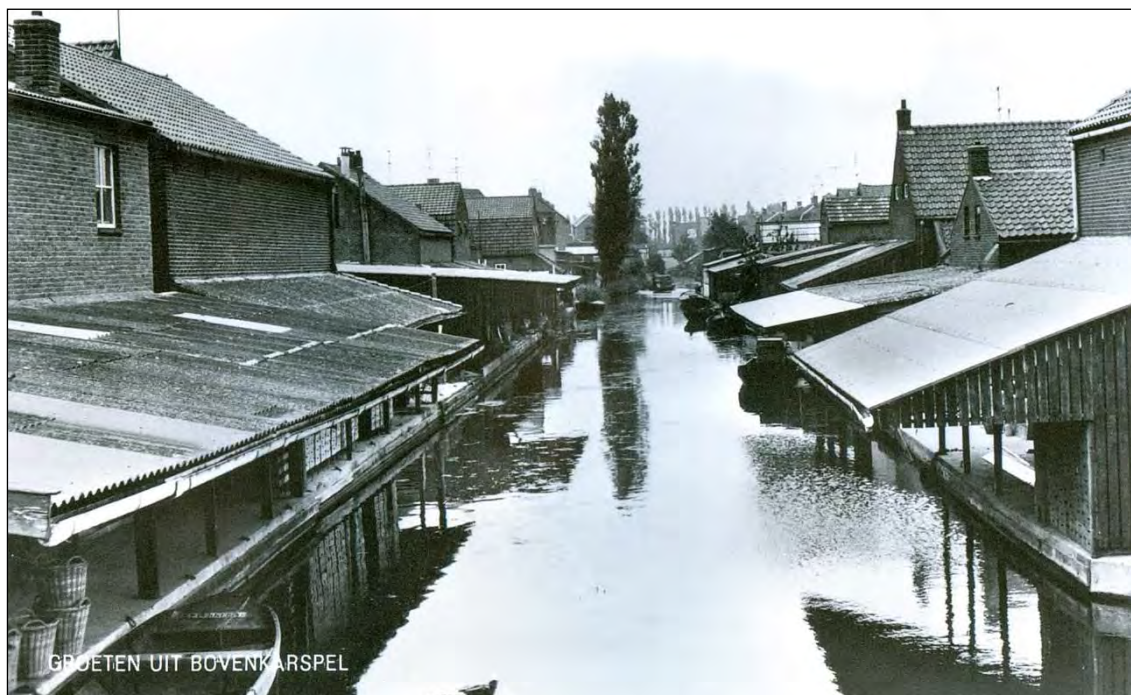
Afb. 44 In de Streek was en is het normaal om een overkapping boven de aanlegplaats van de schuit te bouwen. Hier een foto van een van de grotere sloten in Bovenkarspel uit de 20ste eeuw.
