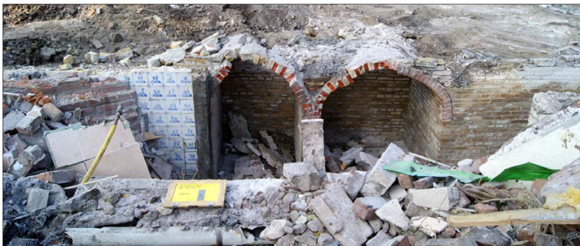
Afbeelding 16. In Fase 3 werd aan de oostzijde van het huis een kelder met een dubbele nis gebouwd. In fase 4 werd de rechte trap van gele bakstenen vervangen door een hoektrap opgebouwd uit machinaal gefabriceerde bakstenen (links). De foto is richting het westen genomen.
