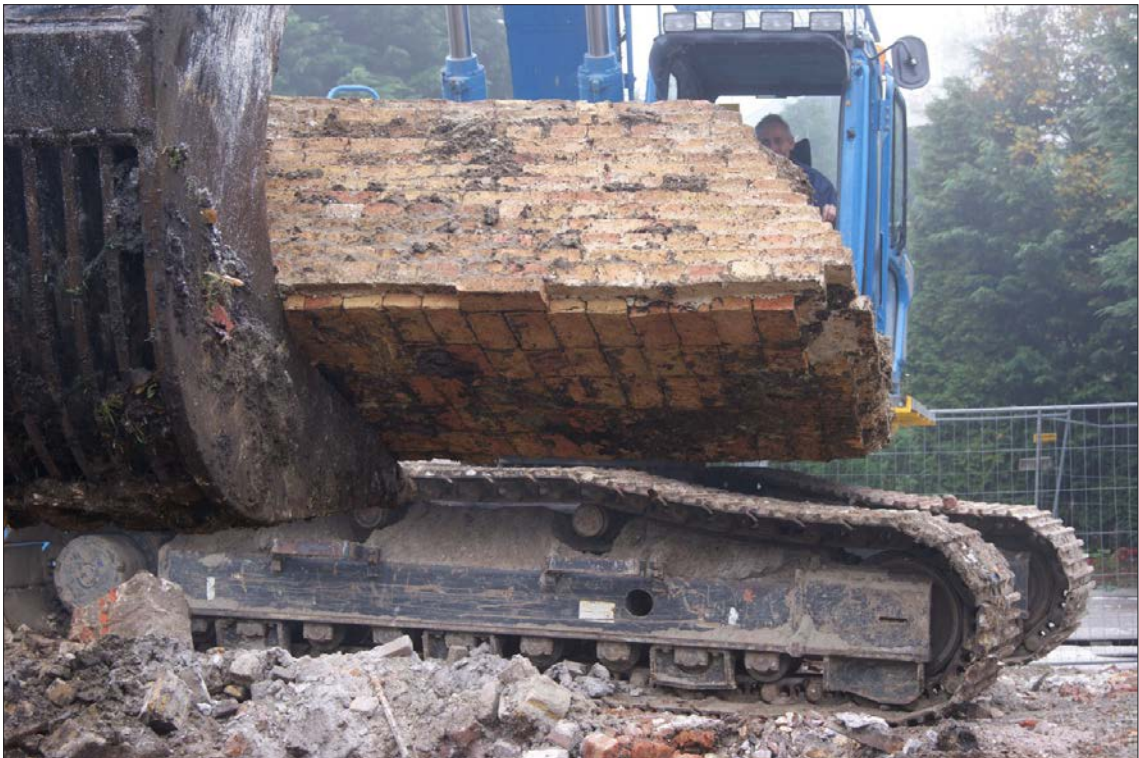
Afbeelding 9. Werk in uitvoering. Met een grote dieplepelkraan worden zowel de oude als de recente de funderingen verwijderd.
