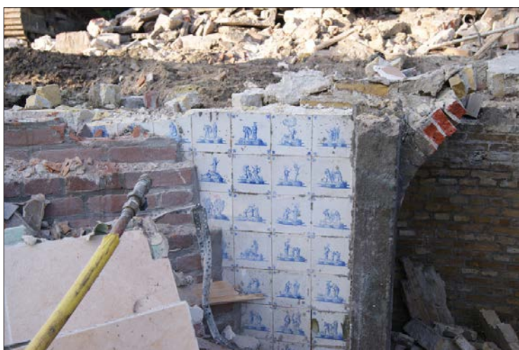
Afbeelding 26. (boven en helemaal boven) De westelijke muur van de lange kelder uit fase 3 was betegeld met wandtegels.
