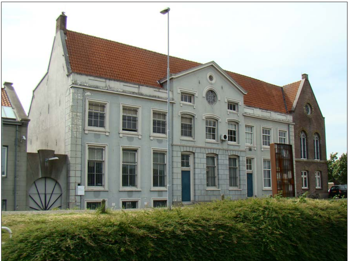
41. Situatie in 2008 voorafgaand aan de restauratie. De gevel is grotendeels ongewijzigd gebleven sinds de bouw in 1868.
