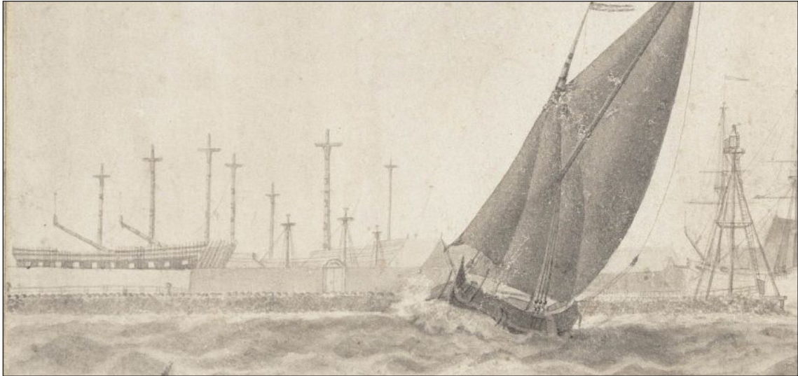
29. Detail van een tekening van Pieter Aartsz Blaauw, eerste helft 18de eeuw (collectie Westfries Museum). Geheel links achter omheining ligt een schip in aanbouw op de werf van de Admiraliteit, gezien vanuit het zuidoosten.
