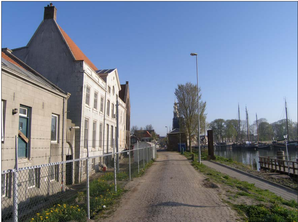
20. Situatie in 2010 tijdens de renovatie.
