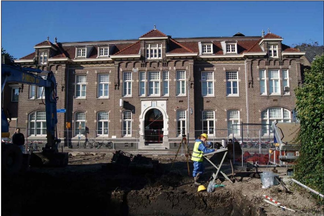
3. Vijzeltuin Oost, zone 1, werkput 7. Op de achtergrond het voormalige Snouck van Loosenziekenhuis aan de Vijzelstraat.
